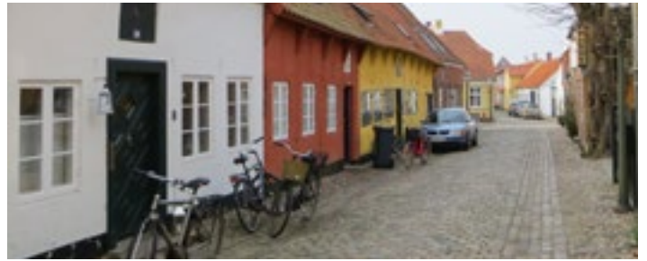
Den sammenhængende boderække på Præstegade fra begyndelsen af 1600-tallet, alle bygninger er fredede.
