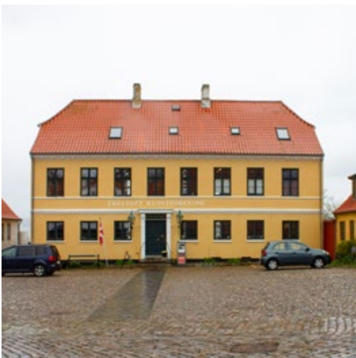
Det nyere rådhus, opført 1840, SAVE-værdi 3.
