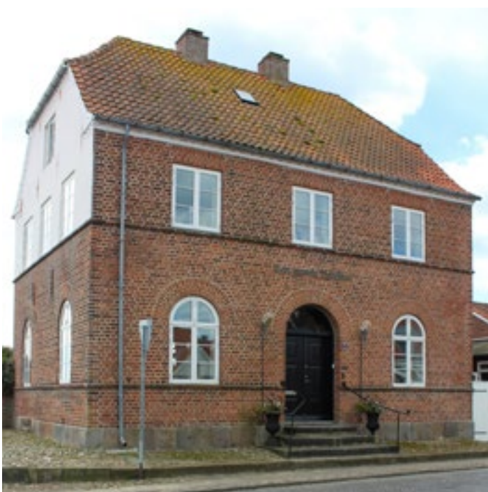
Den Gamle Toldbod, V. Strandbjerg 1, opført 1843, fredet.
