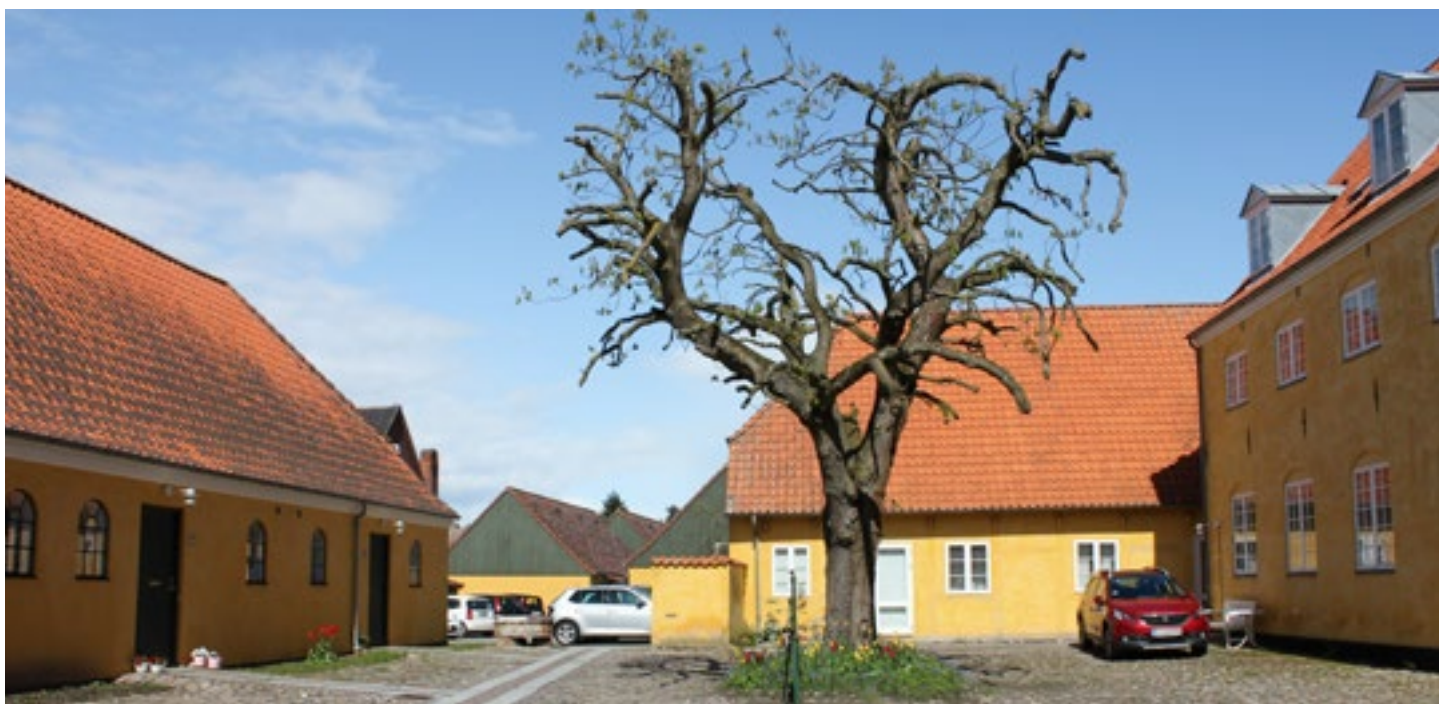
Kammerrådgårdens pigstensbelagte baggård med sidehuse og baghus. Bygningerne er opført i løbet af 1700-tallet, og pakhuset i højre side af billedet er opført i 1840, alle fredede.
