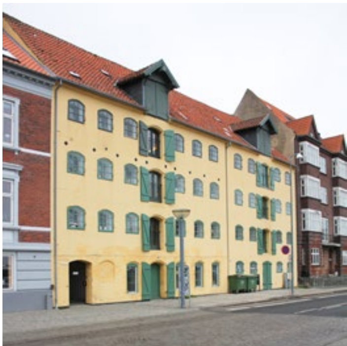
Pakhuset med front mod havnen, opført 1845, SAVE-værdi 2 i kommuneplan.
