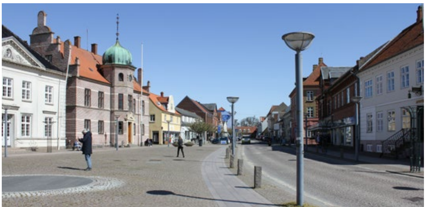
Kig i nordlig retning fra det centrale torv ved Storegade, som er afgrænset af flere prominente bygninger i to etagers højde - i venstre side: bankbygningen fra 1902, det tidligere rådhus - nu politistation - fra 1854. I højre side: apoteket fra 1799.
