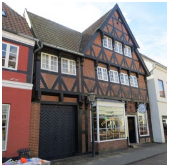
Korshuset på Nederdammen 28, opført i midten af 1600-tallet, fredet. Bindingsværkshuset med udkraget, knægtbåret øvre stokværk, tavli i blankt rødt mønstermurværk og tegltag repræsenterer en almindelig bygningstype i Ribe.
