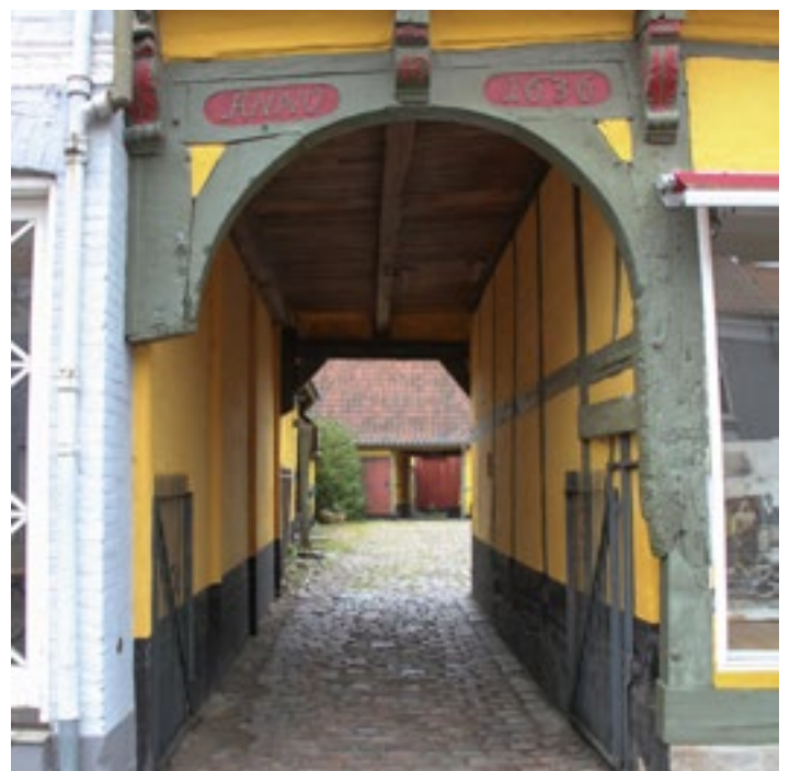
Porten ind til den brostensbelagte baggård til Brogade 16 med side- og baghuse i et mere enkelt udtryk end den detaljerede facade mod gaden.
